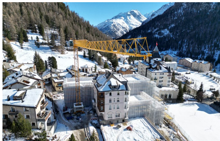
Baustelle Sunstar Hotel Pontresina
